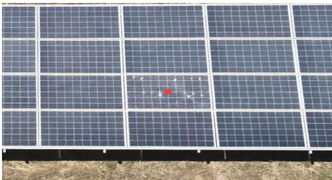
DJI_20230719115220_0804_V.JPG DJI Mavic 3T Enterprise
